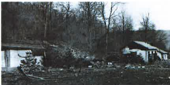
Nach der Explosion vom 10.4.1917 (Burkhardt 2012, S. 109)
