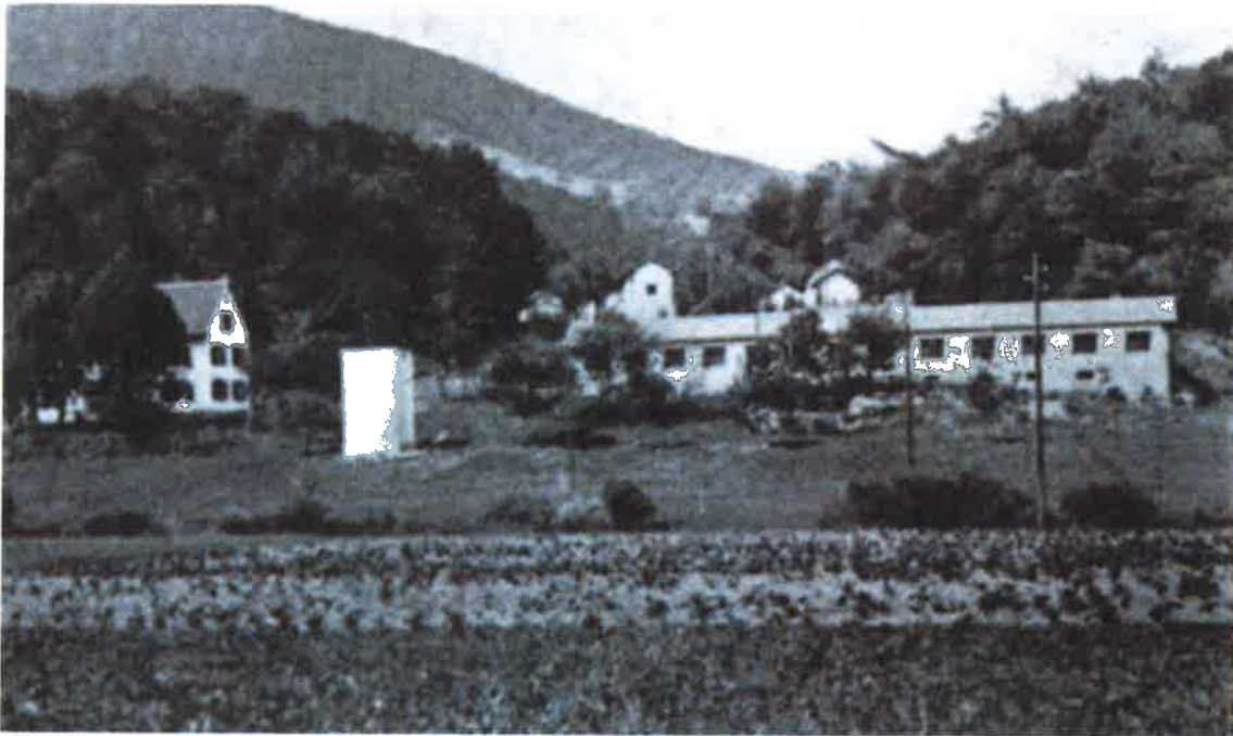
Ansicht von Süden, um 1913 (Burkhardt 2012, S. 106)
