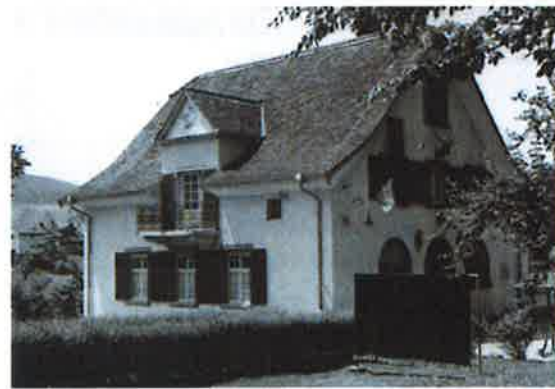
Verwaltungsgebäude, 1955 (Burkhardt 2012, S. 109)
