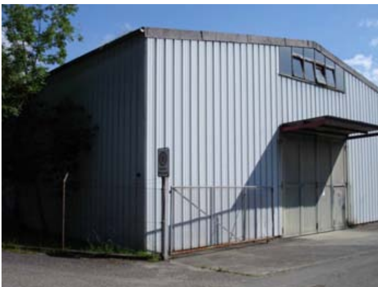
22. Lagerhalle von 1975, Westseite
