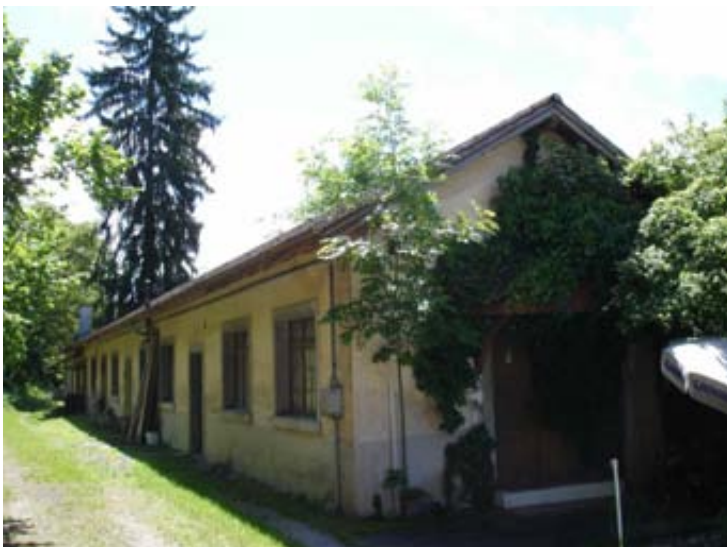
16. Werkstattgebäude, Nord- und Westseite
