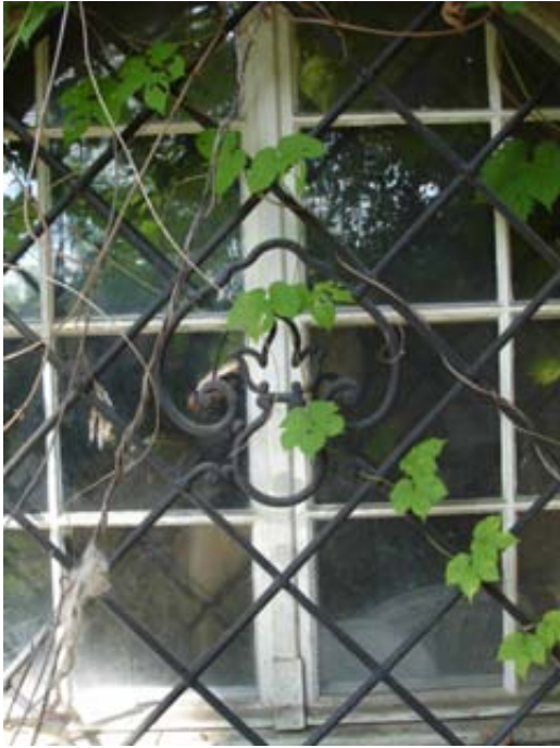
6. Vergittertes Kellerfenster Südseite
