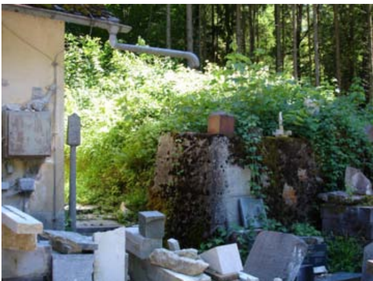
19. Befestiger Wall bei ehemaligem Sprengstoffmagazin
