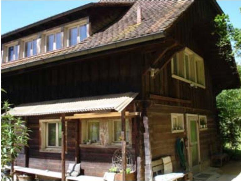
17. Remise, Ost- und Nordseite
