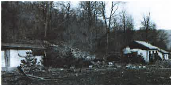
Nach der Explosion vom 10.4.1917 (Burkhardt 2012, S. 109)
