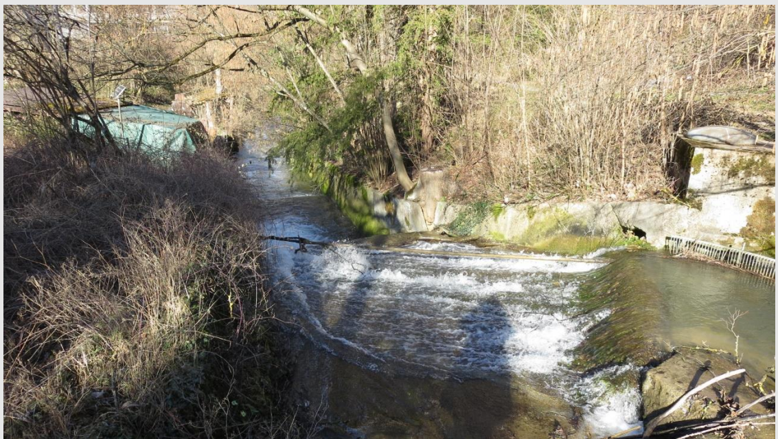
Abb 25. Orisbach – Bachverbauung im Bereich des Quartierplan-Perimeters
