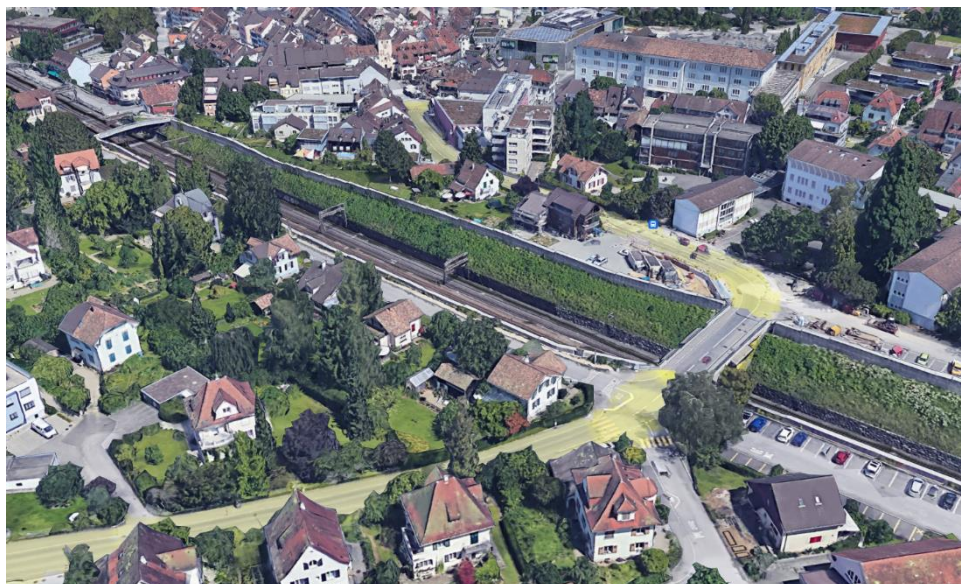
Abb. 9 Bahneinschnitt von Süden
