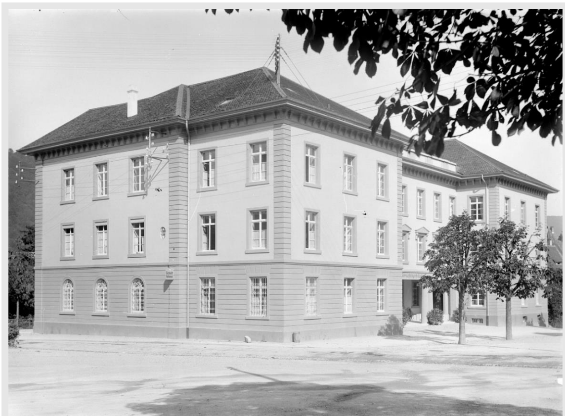
Abb 13. Gerichtsgebäude nach der Fertigstellung 1920 (Quelle: Bauhistorisches Gutachten Kantonsgericht BL, 2017)
