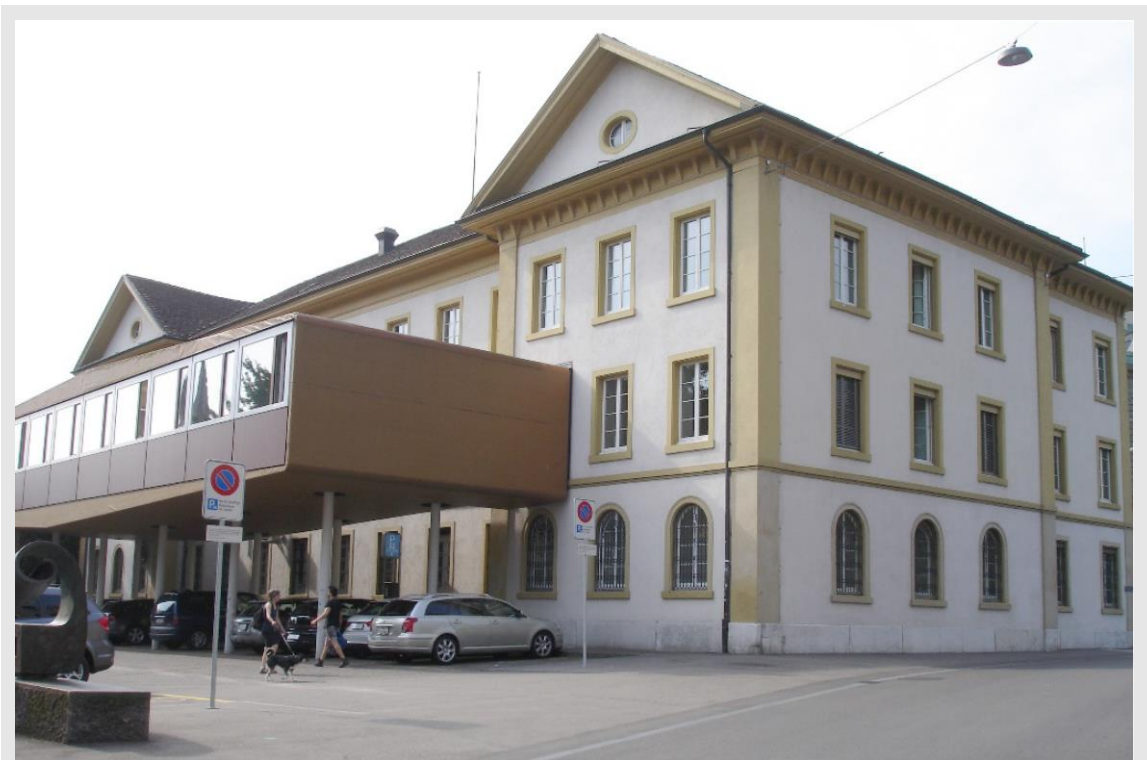
Abb 15. Gerichtsgebäude mit provisorischem Pavillon (Quelle: Bauhistorisches Gutachten Kantonsgericht BL, 2017)
