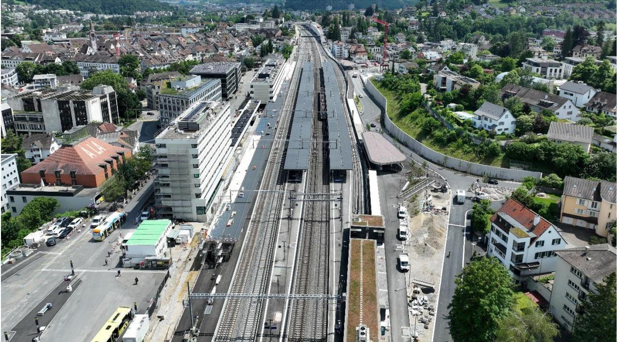
Die beiden Fotos zeigen den Bahnhof Liestal in Richtung Olten gesehen. Das obere Foto zeigt den Stand der Arbeiten am 4. Juni 2024. Das Foto unten wurde im August 2020 aufgenommen. Das Gleisfeld im Bahnhof wurde seither um bis zu 25 Meter gegen Süden (rechts im Bild) verbreitert. Zuvor durchliefen drei SBB Streckengleise den Bahnhof, nun sind es vier, plus das zusätzliche Mittelperron. Die neuen Gebäude am Bahnhof entstanden ab Anfang 2022.
