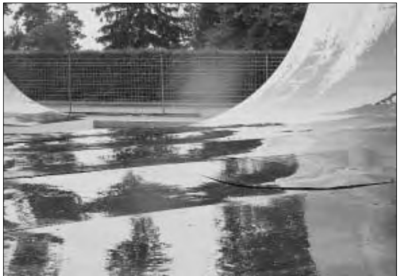
Die Skateboardanlage Gitterli wies gravierende Sicherheitsmängel auf. Auf Empfehlung der Beratungsstelle für Unfallverhütung (bfu) liess der Stadtrat sie im Juli 2004 schliessen. Inzwischen wurde sie abgebrochen.
